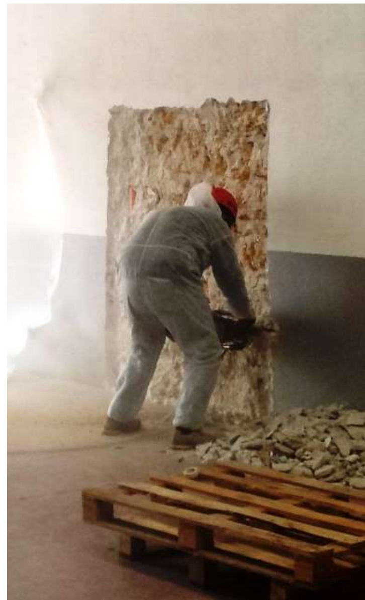
Taglio di forma semicircolare allungata mediante mototroncatrice eccentrica
