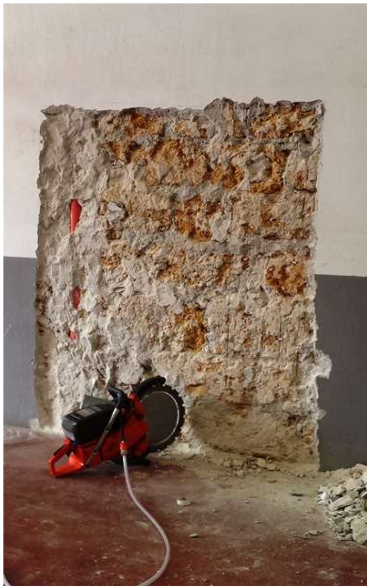
Taglio di forma semicircolare allungata mediante mototroncatrice eccentrica
