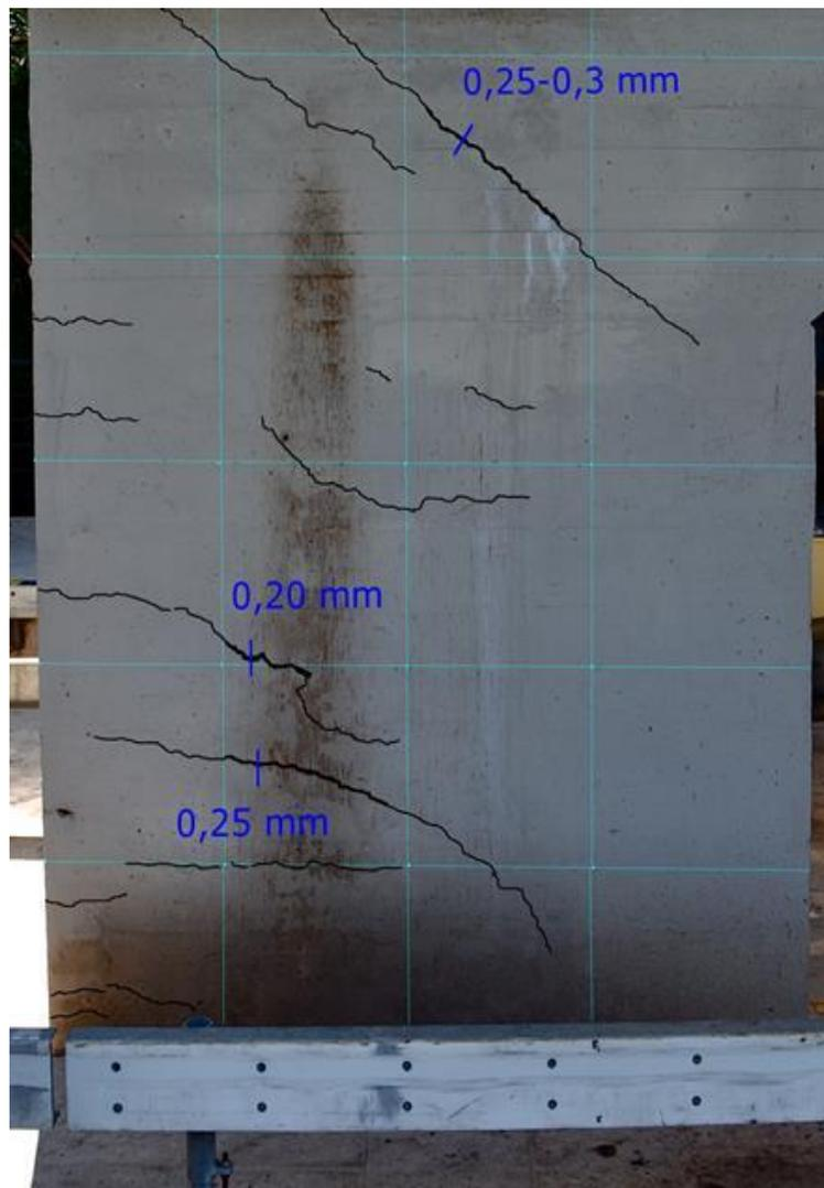
I sopralluoghi devono rilevare anche la presenza di eventuali **fessurazioni ritenute significative degli elementi strutturali indagando, tramite il rilievo del quadro fessurativo, la causa:** ritiro plastico, fessurazioni da taglio in travi, fessurazioni flessionali in travi, fessurazioni in tramezzi o muratura di tompagnamento, cedimenti differenziali delle fondazioni, velocità di applicazione dei carichi.
