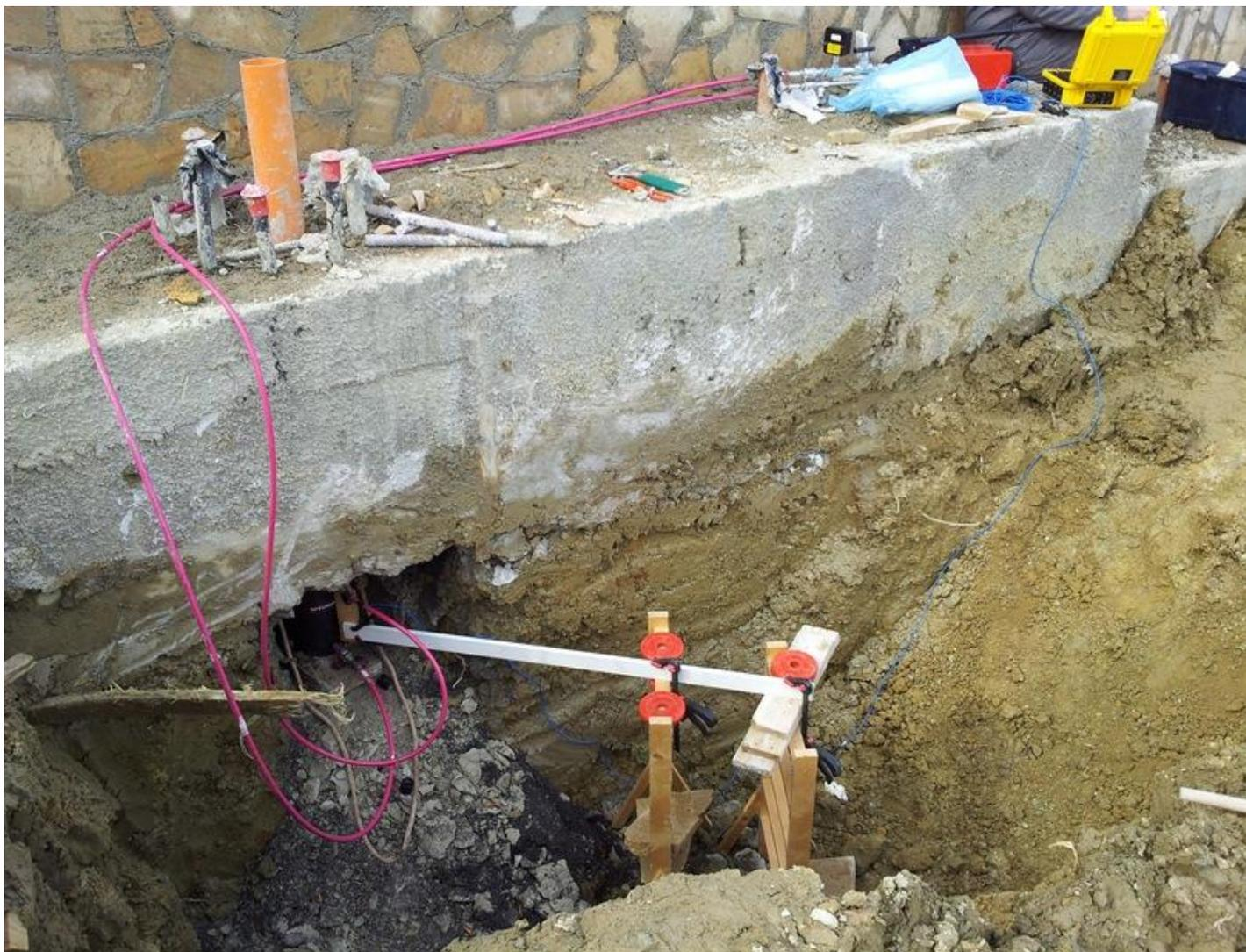
**Prova di carico su palo: contrasto costituito dalla base del muro di sostegno**
